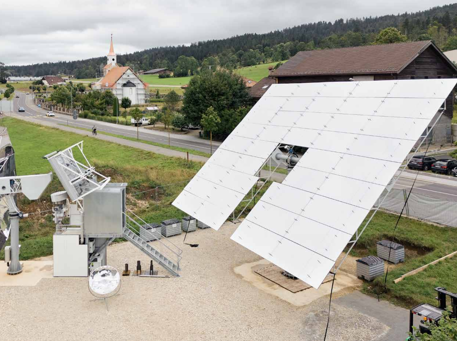
Die grossen flachen Spiegel, Heliostaten genannt (rechts), im Industriegebiet von La Chaux-de-Fonds fangen die Sonnenstrahlen auf und richten sie auf den Parabolspiegel (links). Der konzentriert sie tausendfach auf den Schmelztiegel (Bildmitte). Dort entstehen Temperaturen von etwa 2000 Grad, wie in einem konventionellen Stahlofen.
